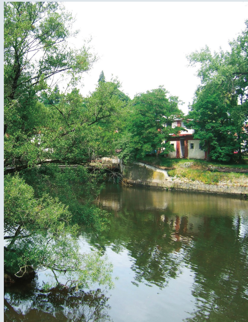
V tomto romantickém zákoutí pilně pracují dvě turbosoustrojí malé vodní elektrárny. (© ČEZ)
